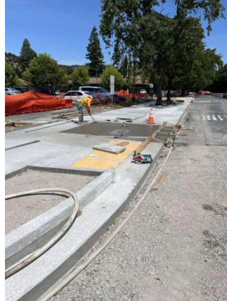
Figure 2. - Sidewalk Concrete Pour Backs
